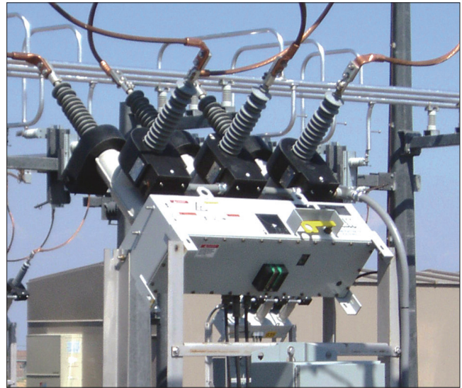
Este modelo de religador Viper-S possui TCs nos lados de carga e de fonte e apresenta montagem em ângulo de 45°, adequada para aplicações que exigem a mesma altura dos conectores.
