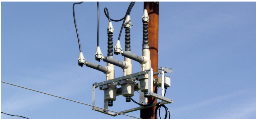
15kV 杆装中心型 Viper-ST 重合器
