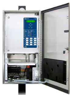
SEL-651R 前置控制装置，适用于传统重合闸应用。
