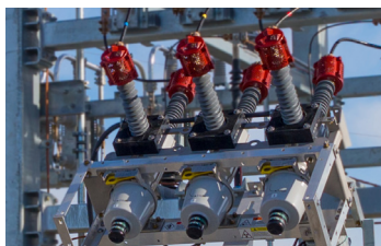
Viper-ST 重合器配一组外置电流互感器。 可在另一侧增配第二组电流互感器。
