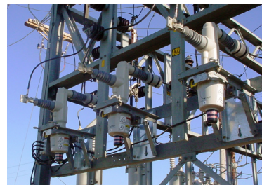
采用 Z 型模块的 Viper-ST 重合器改造安装， 每个模块配独立支架。
