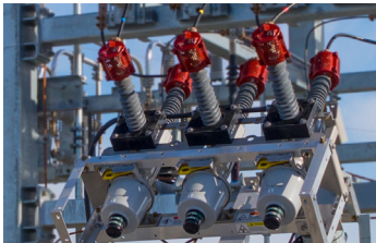
Reconectador Viper-ST con un juego de TC externos. En el otro lado puede proveerse un segundo juego de TC.
