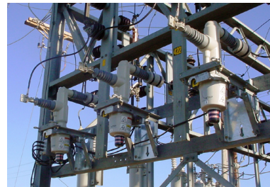
Instalación retroadaptada con reconectador Viper-ST de módulo en forma de Z sobre bastidores individuales.
