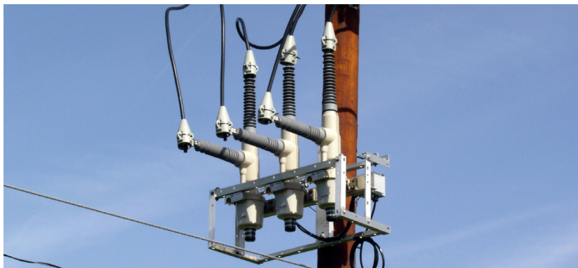
Reconectador Viper-ST de 15 kV para montaje en poste central
