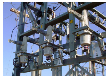
Instalação retroprojetada com religador Viper-ST de módulo em forma de Z em quadros individuais.
